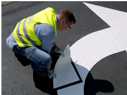
Figura 18. Instalación preformada
